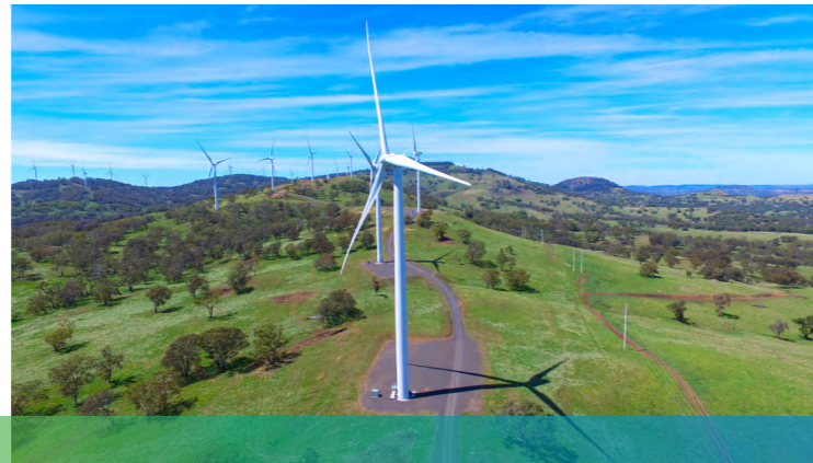
澳大利亚新南威尔士州白石风电场 175MW 项目
