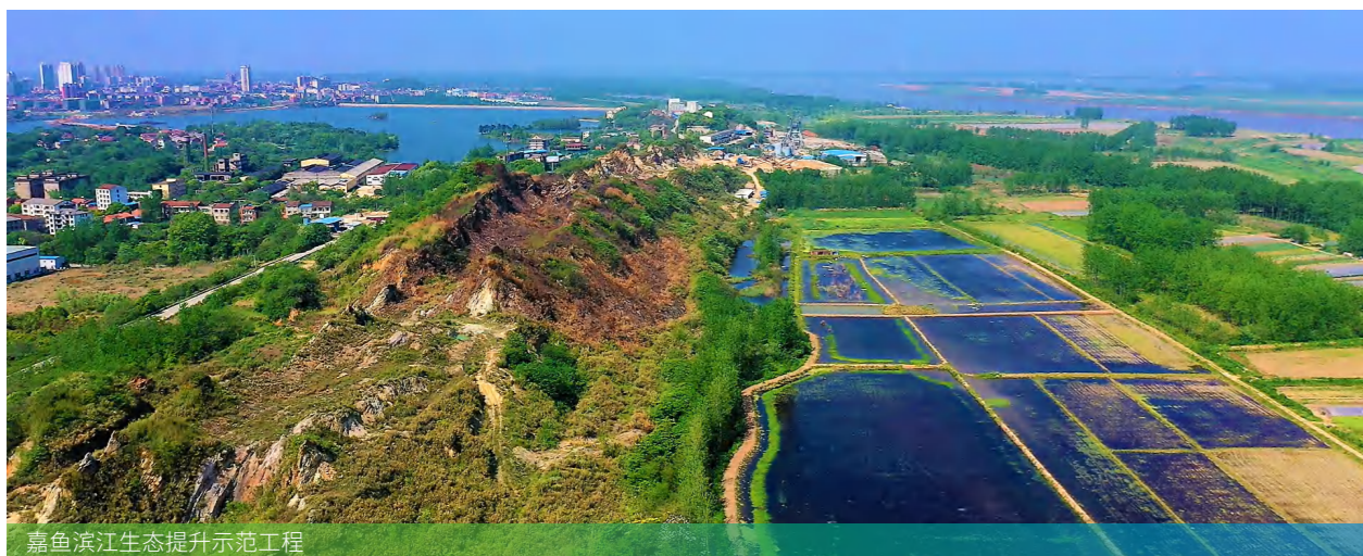
嘉鱼滨江生态提升示范工程
