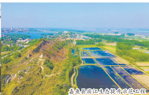
嘉鱼县滨江生态提升示范工程
